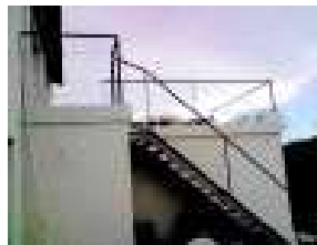
Rampe avec câble
